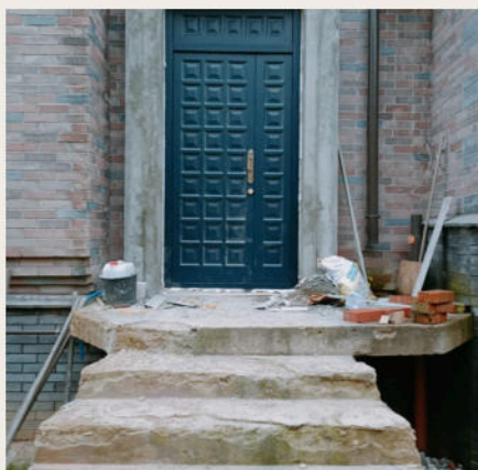
Та же дверь с улицы, сразу после монтажа — наша работа
