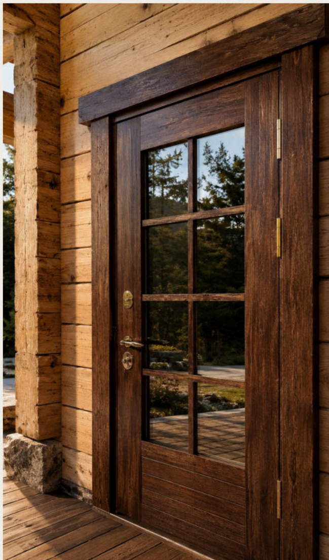
Дверь под навесом крыльца
