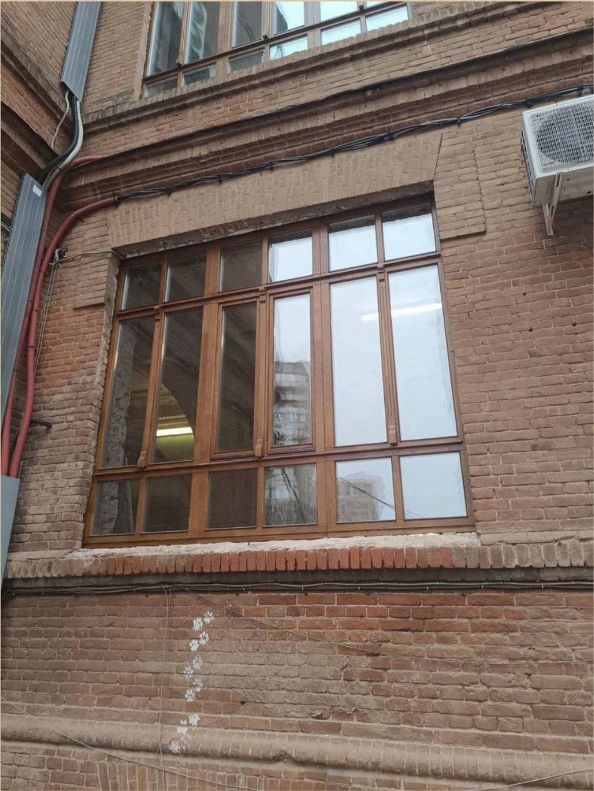
Окна после монтажа, декабрь 2025 года.
