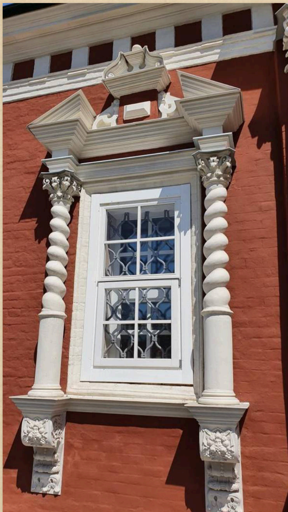
Окна на объекте.
