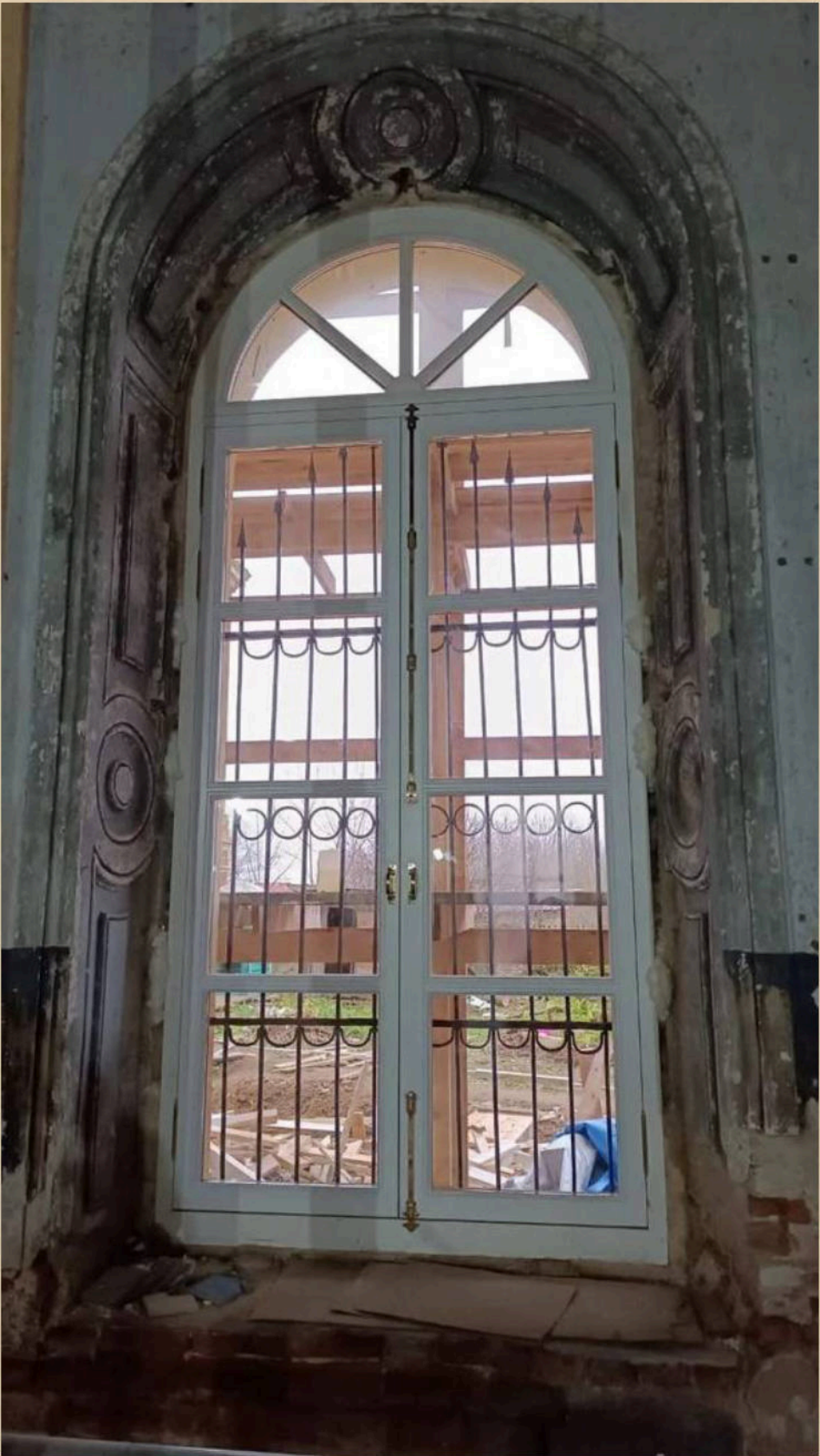
Монтаж окон, май–июнь 2024 года.
