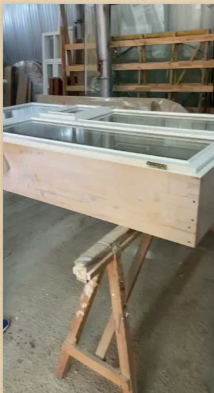
Сборка оконного блока
